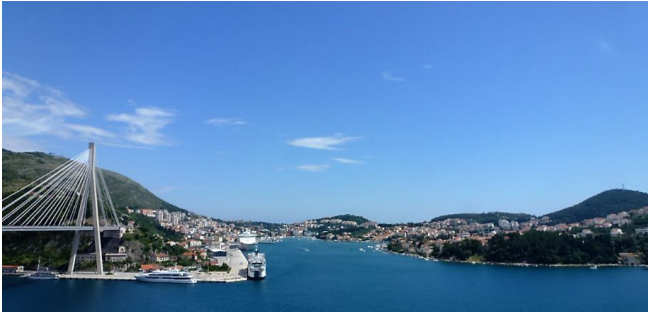
De nieuwe brug met de cruise terminal.
